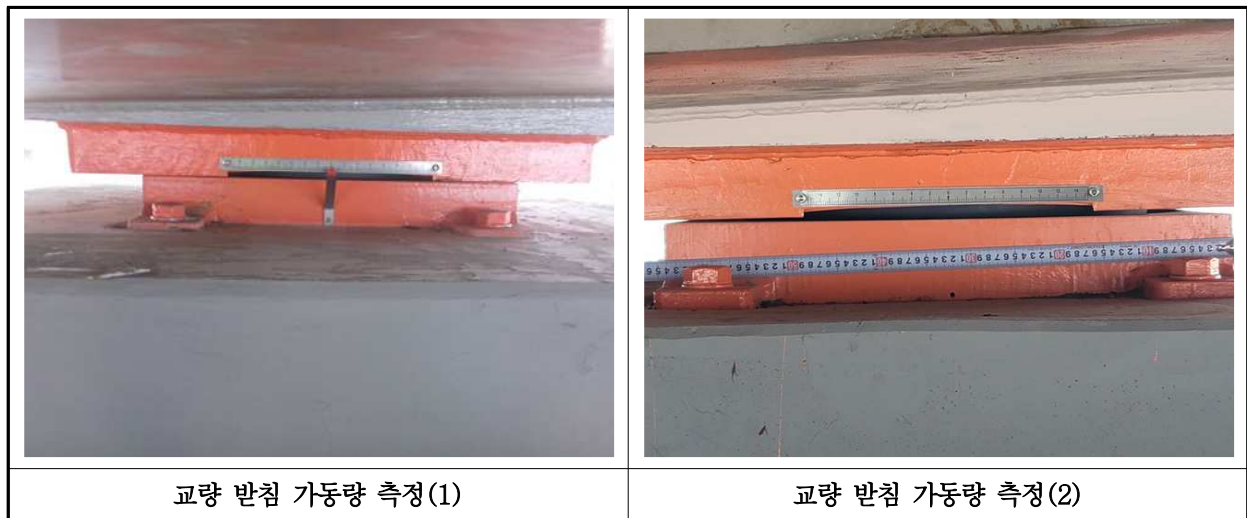
【사진 2.3.17】 교량받침 이동량 측정
