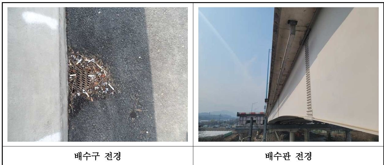
【사진 2.3.53】 배수시설 전경
