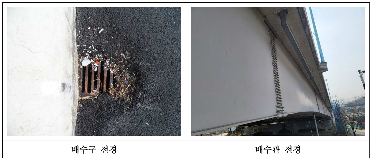
【사진 2.3.23】 배수시설 전경
