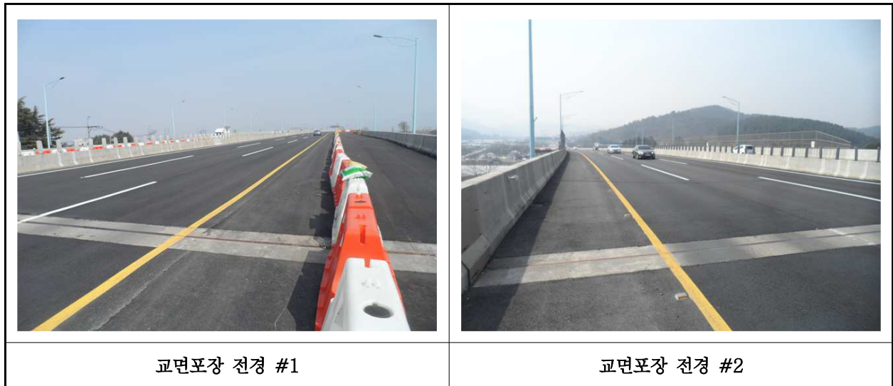
【사진 2.3.51】 교면포장 전경
