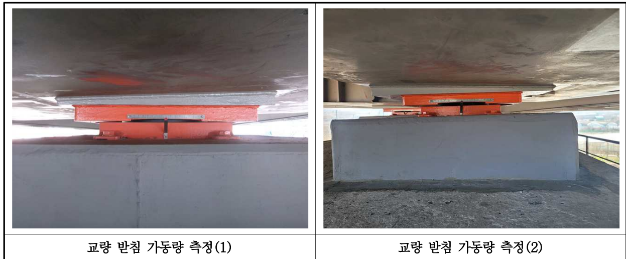
【사진 2.3.47】 교량받침 이동량 측정
