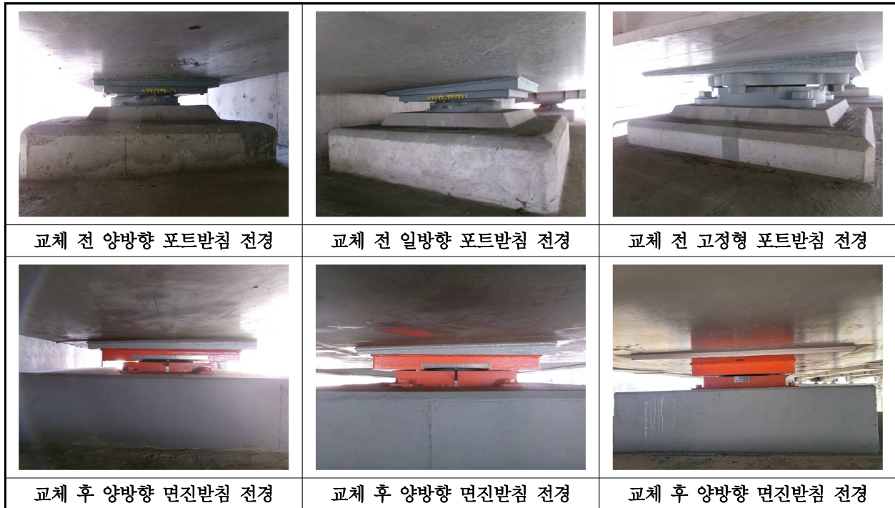
【사진 2.3.14】교량받침 전경
