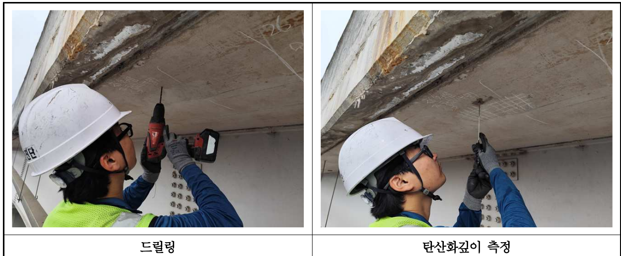
【사진 2.4.3】 탄산화 깊이 측정 현장사진
