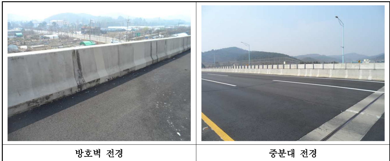
【사진 2.3.55】 방호벽 및 중분대 전경
