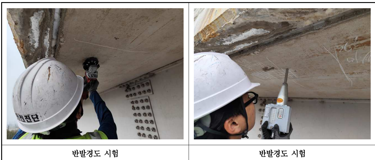
【사진 2.4.2】 반발경도시험 현장사진
