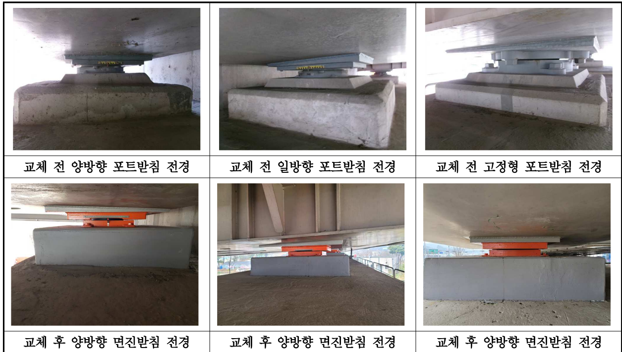
【사진 2.3.44】 교량받침 전경
