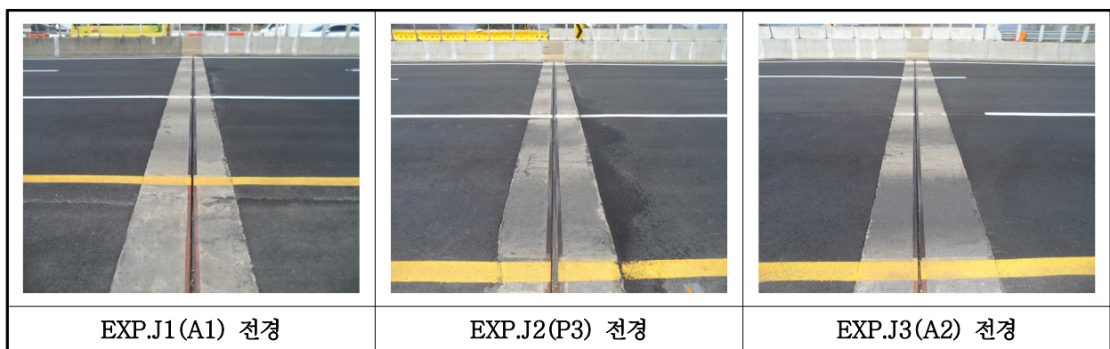
【사진 2.3.48】 신축이음장치 전경
