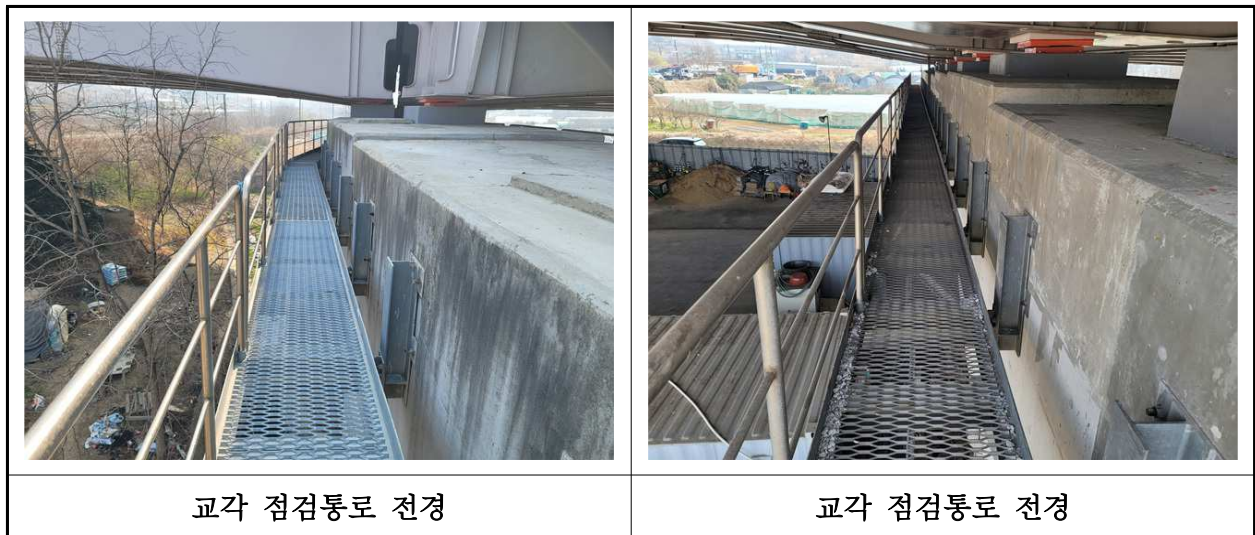
【사진 2.3.27】 교량 점검시설 전경
